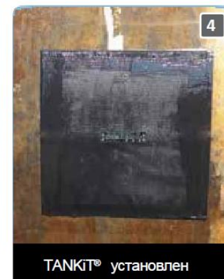
Монтаж нескольких слоев Kevlar® со специальной смолой
